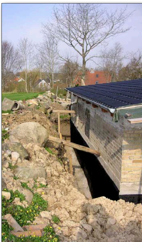
Der graves ud til drænen ved baghuset
