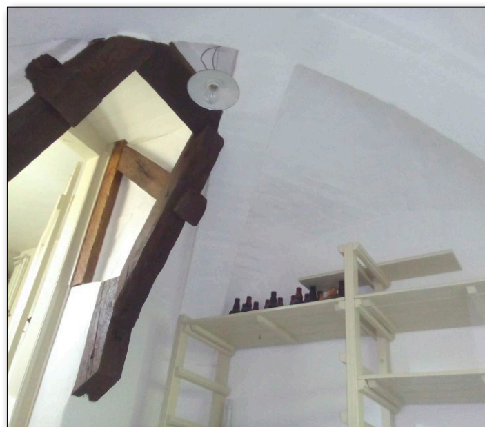
Den flotte hvelving i kælderen på Det lille hus ved kirken
