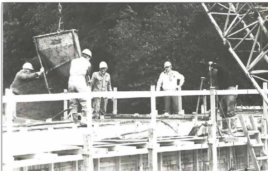
Billede fra byggearbejdet da viadukten mellem Storegade og Kirkebakken blev bygget.
